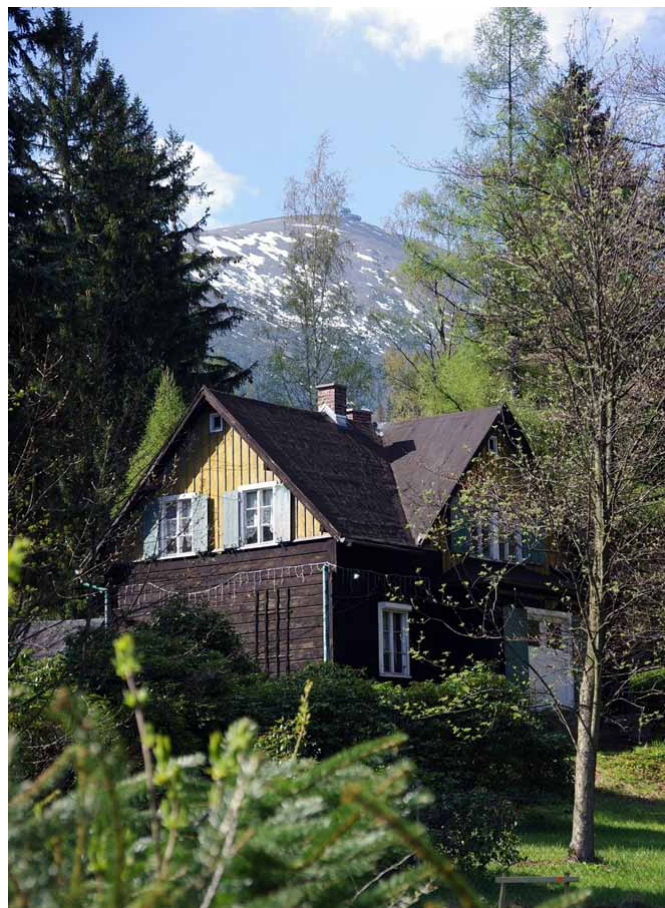
Fluchtburg (przed pracami remontowymi w latach 2018-2020). W oddali widok na Śnieżkę
