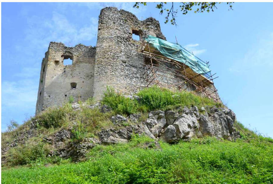
Na zamku cały czas trwają prace konserwacyjne
