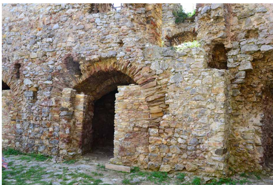
Wejście do jednego z nielicznych pomieszczeń „pod dachem”
