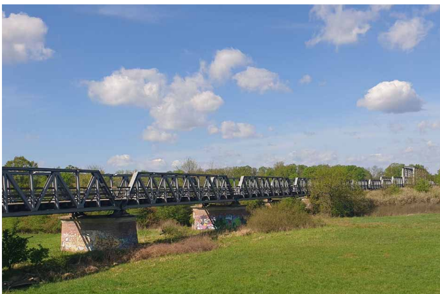
Stany. Ponad pół kilometra stalowych przęseł
