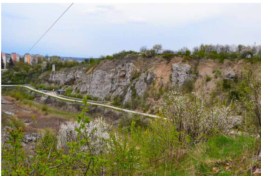
Wschodnia ściana wyrobiska
