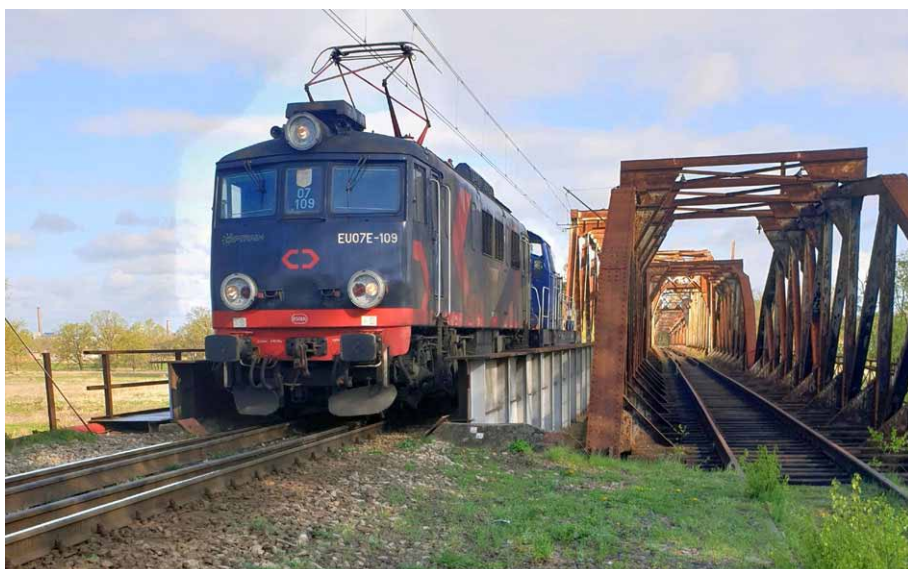
Brzeg Dolny. Rdzawa uroda podwójnego mostu kolejowego
