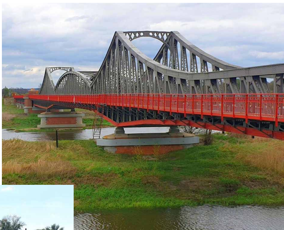
Ścinawa. Malowniczy most drogowy po dwuletnim generalnym remoncie
