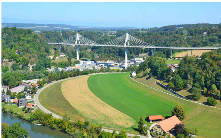
Pont de la Poya – widok z wieży katedry św. Mikołaja.
