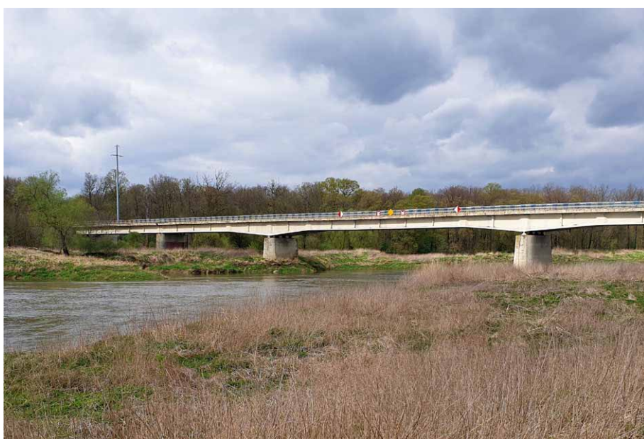
Lubiąż. Przęsło nurtowe
