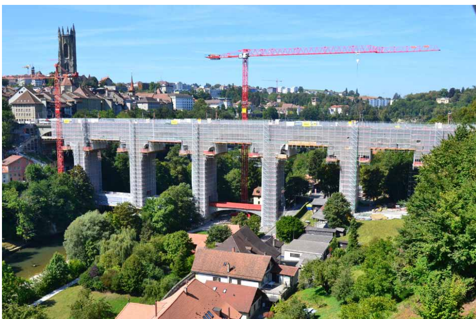
Pont de Zaehringen w „szacie remontowej”
