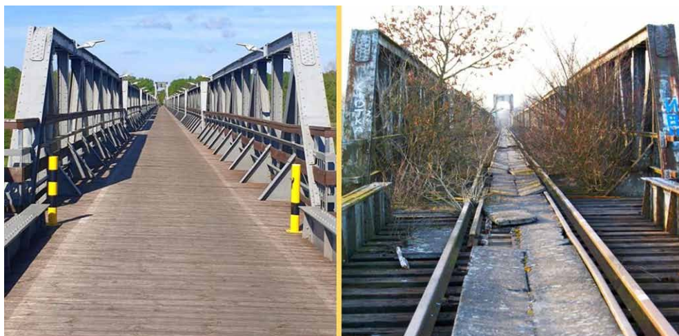
Stany. Wjazd na most w roku 2024 i... dziesięć lat wcześniej
