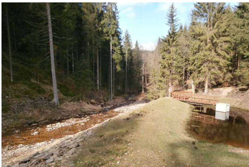
Urządzenia hydrotechniczne przy Drodze Justyny
