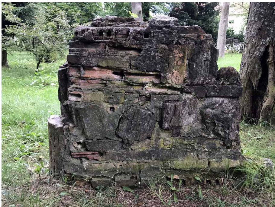
Z tyłu pozostałości pomnika widoczne są cegły, którymi wypełniono przestrzeń pomiędzy skalnymi blokami
