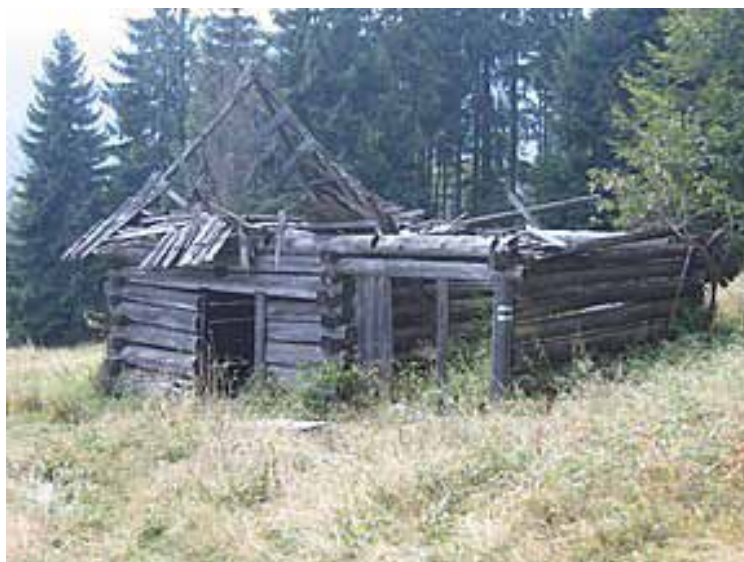
Ruina zabytkowego szałasów na polanie Stawieniec
