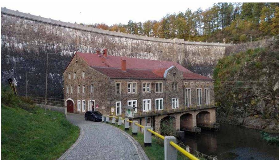
Elektrownia przy zaporze na Jeziorze Żłotnickim
