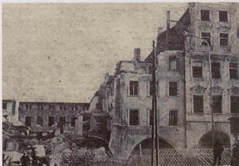
Jelenia Góra, wyburzanie kamienic w pierzei północnej rynku
