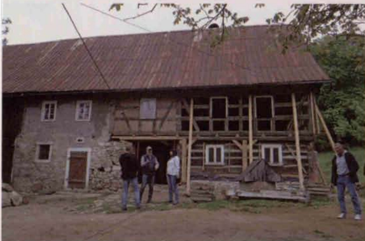
Dom przysłupowy w Siedlęcinie w trakcie remontu
