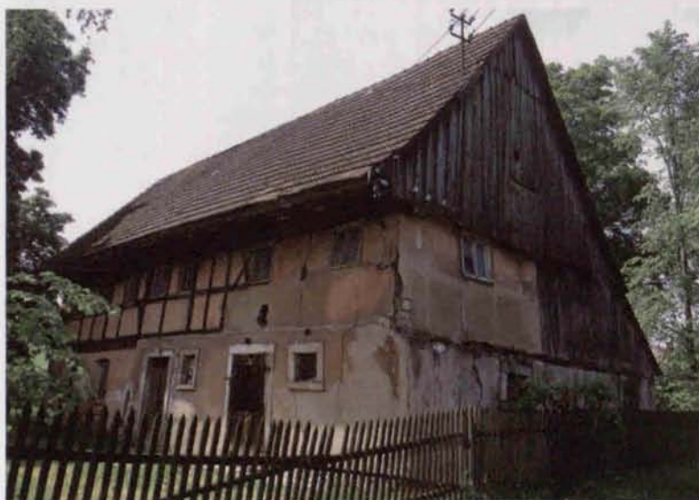
Opuszczony dom o konstrukcji mies- zanej w Pokrzyw- niku
