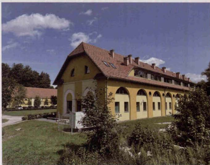
Odnowione obiekty w Bukowcu
