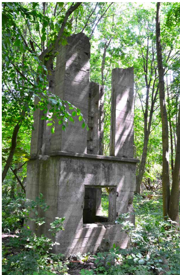
Jeden z nielicznych zachowanych elementów konstrukcji linii transportu urobku z kopalni do cementowni
