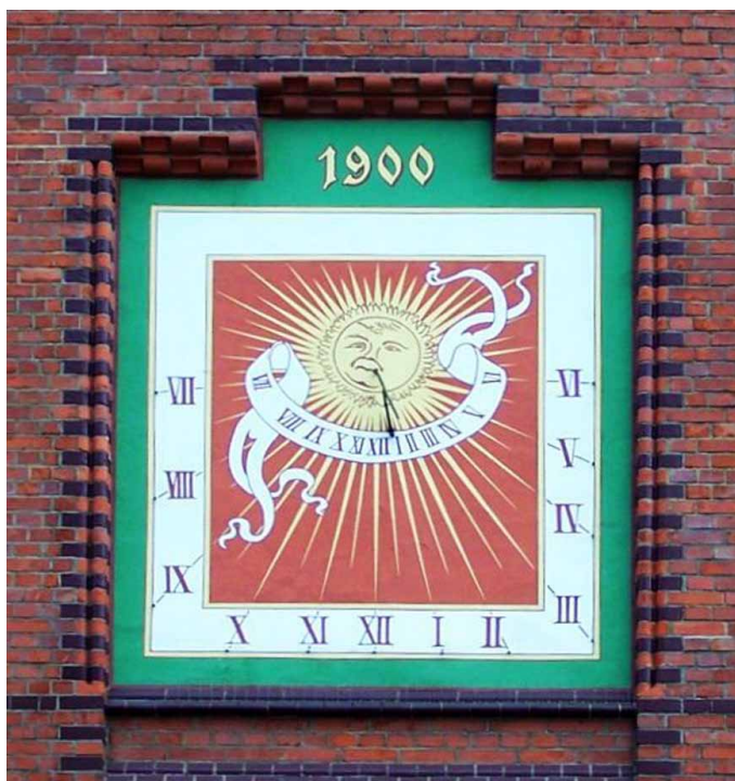
Na budynku dawnej szkoły (ul. Poznańska)
