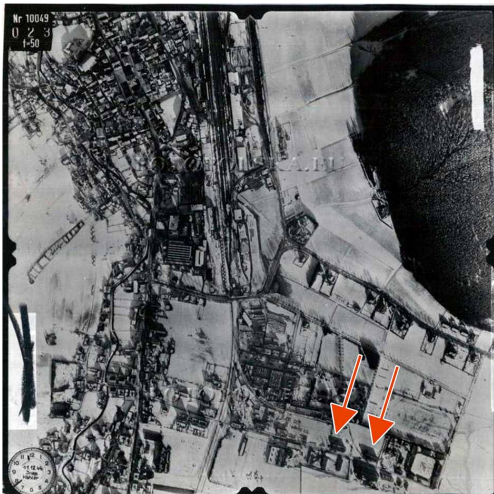
Zdjęcie lotnicze Lubawki z końca 1944 roku. Strzałki wskazują dwa istniejące do dziś murowane budynki poobozowe. Źródło: fotopolska.eu
