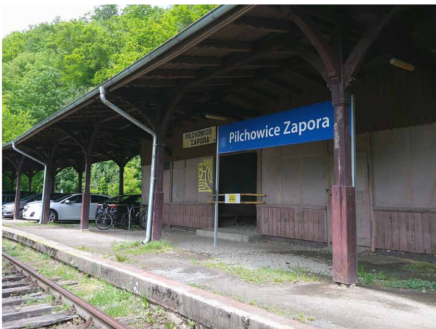
Stacja Pilchowice Zapora czeka na pociągi
