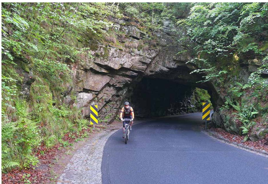
Tunel skalny na drodze do Piechowic
