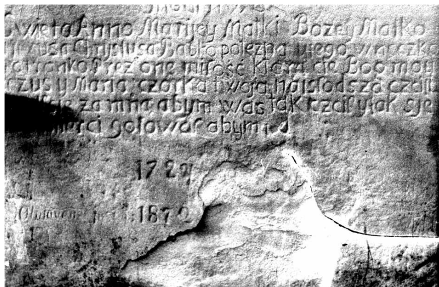
Tekst modlitwy wotywno-fundacyjny na licu cokołu. Fot. Ryszard M. Remiszewski.
