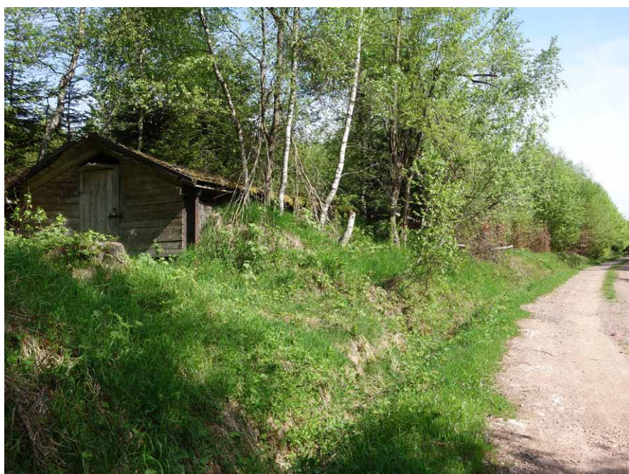
Droga leśna (dojazd pożarowy 32) i drewniana budowla wspomniana w tekście
