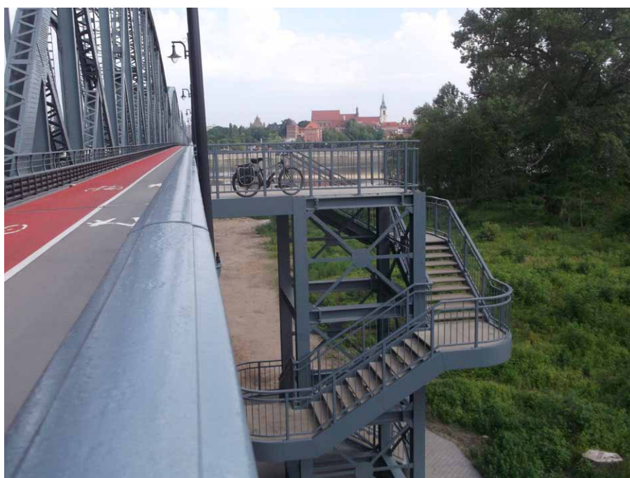
Zejscie z mostu do rezerwatu „Kępa bazarowa”
