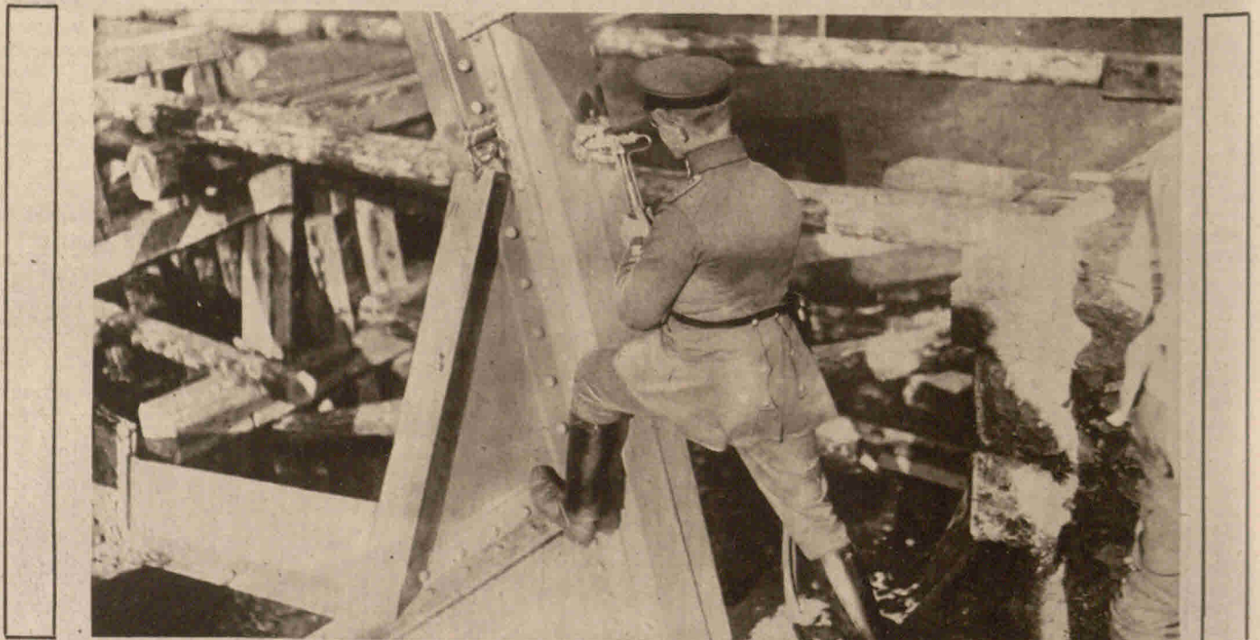
Ein deutscher Offizier durchschneidet eiserne Träger der Pillica-Brücke mit einem autogenen Sauerstoffgebläse Eiko-Film O. m. b. H.
