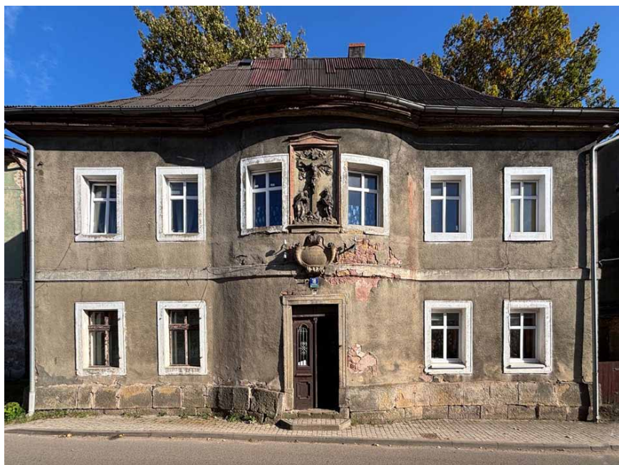
Fasada dawnego szpitala
