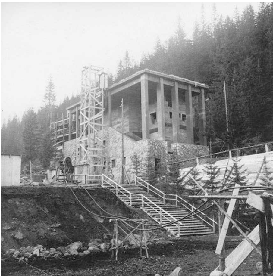
Budowa dolnej stacji kolei w Kuźnicach (1935; źródło: Narodowe Archiwum Cyfrowe, sygn. 3/1/0/8/3822)
