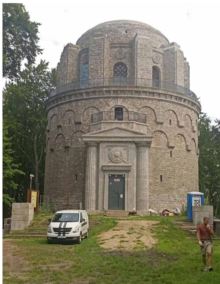
Wieża – stan aktualny 2025 (źródło: materiał własny)
