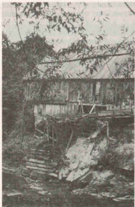
Kacwin – zabytkowy tartak w ruinie, stan z końca lipca 1992 r. Gnije młynówka i podpora koła zamachowego
