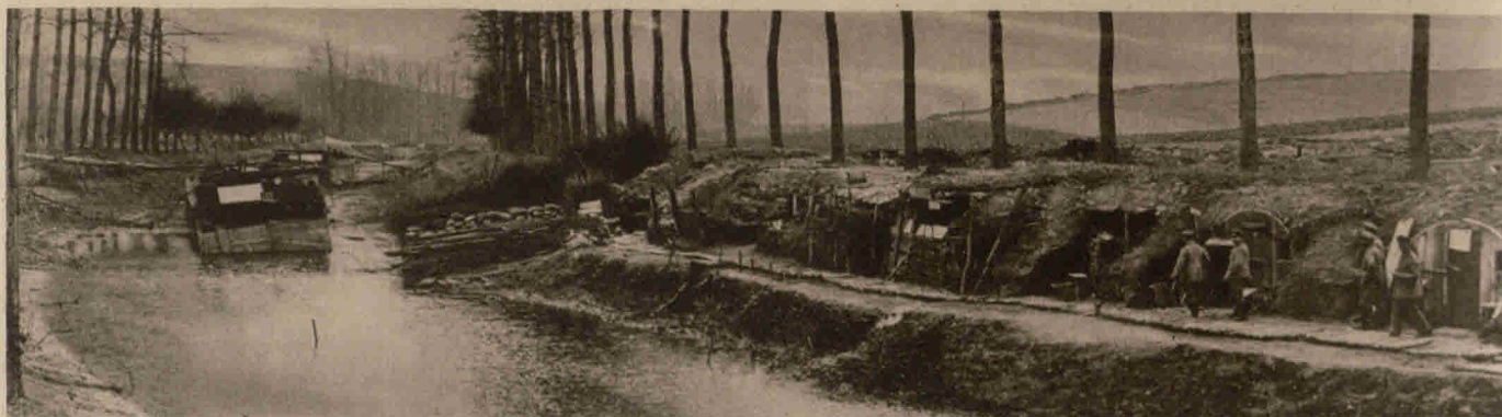
Deutsche Unterstände am Kanal zwischen Dife und Nisne
