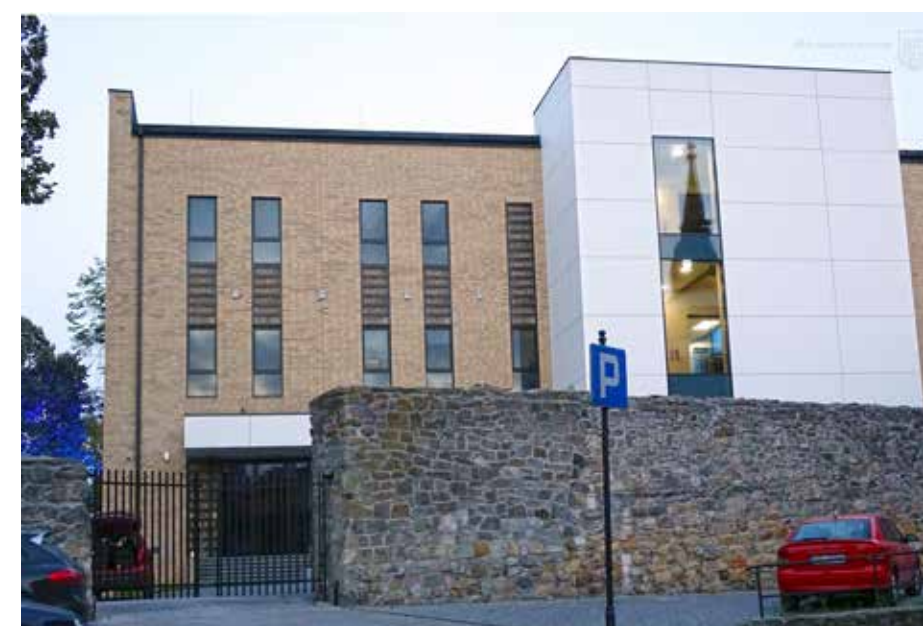
Nowa siedziba MBP-CW po zakończeniu remontu, ul. B. Głowackiego 5, 2018
