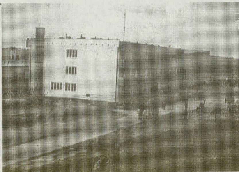
Krzysztofina na placu budowy hotelu przy hali sportowej. Wszak do oddania obiektu pozostało tylko 10 dni.
