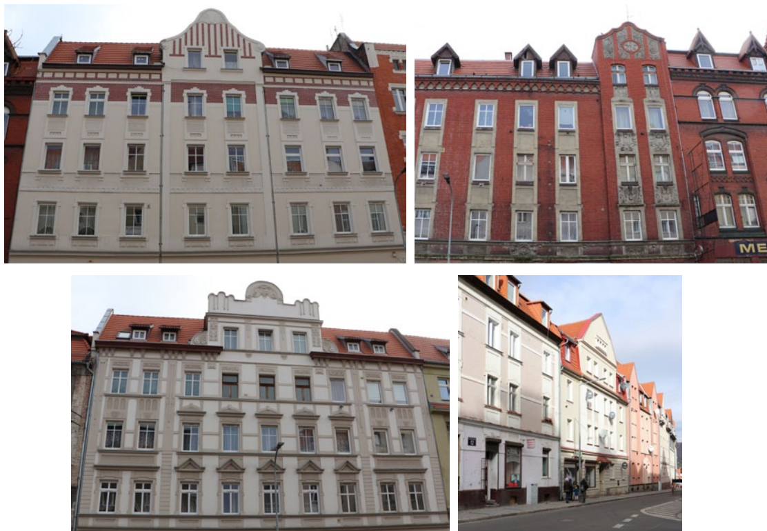
Ryc. 49-52. Elewacje kamienic na Nowym Mieście o różnych formach facjat, przy ul. J. Piłsudskiego 62, 66 i 56. Północna pierzeja ul. I. Paderewskiego. Fot. Bogna Ludwig. Źródło: archiwum Autorki.
