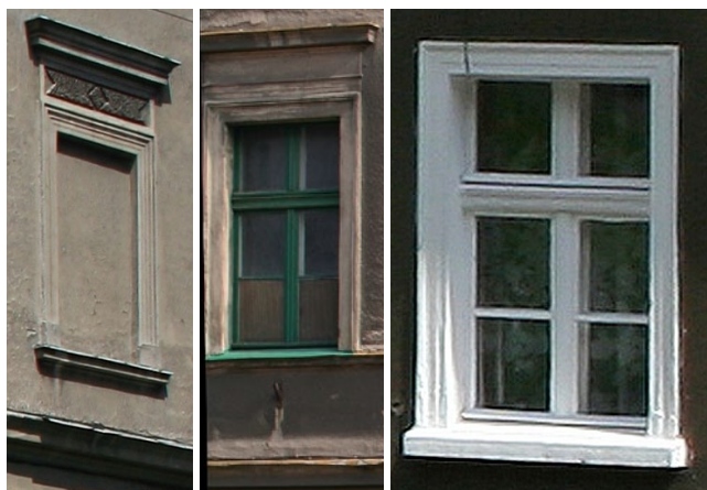
Ryc. 40-43. Projekty opasek okiennych we wzorniku (źródło: A. Geul, Das Äußere... , Bl. 23) oraz przykłady na budynkach w rejonie wałbrzyskim przy ul. Kolejowej nr 16 w Boguszowie, ul. Niepodległości 279 na Podgórzu i ul. Zachodniej na Sobięcinie (fot. Bogna Ludwig, źródło: archiwum Autorki).
