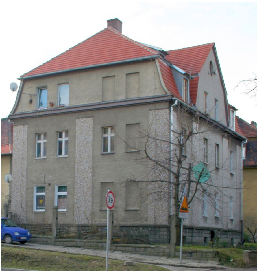
Ryc. 59. Budynek wielorodzinny na dawnym osiedlu fabryki luster, ul. Odlewnicza 6. Fot. Bogna Ludwig. Źródło: archiwum Autorki.
