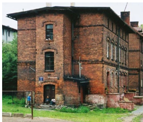
Ryc. 29. Budynek kolejowy ul. Tunelowa 5 przy dworcu Wałbrzych Główny na Podgórzu. Fot. Bogna Ludwig. Źródło: archiwum Autorki.
