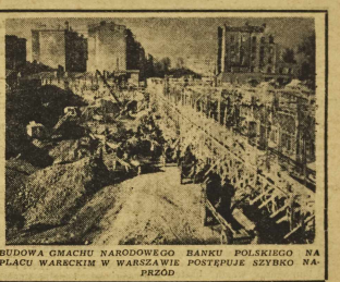
BUDOWA MACZKI NARODOWEGO BANKU POLSKIEGO NA PLACU WARSZAWIE W WARSZAWIE POSTĘPIJE SZYBKO NA PRZÓD
