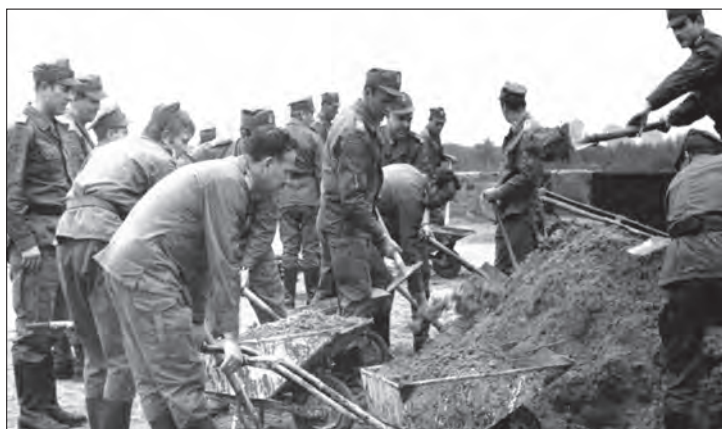
Fot. 5.13. Kadra JW 4030 i JW 2471 uczestniczyła w 1977 r. w porządkowaniu terenu wybudowanego obiektu technicznego
