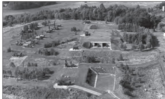
Fot. 9.29. Widok z lotu ptaka na obiekt szkoleniowy w Popielówku
