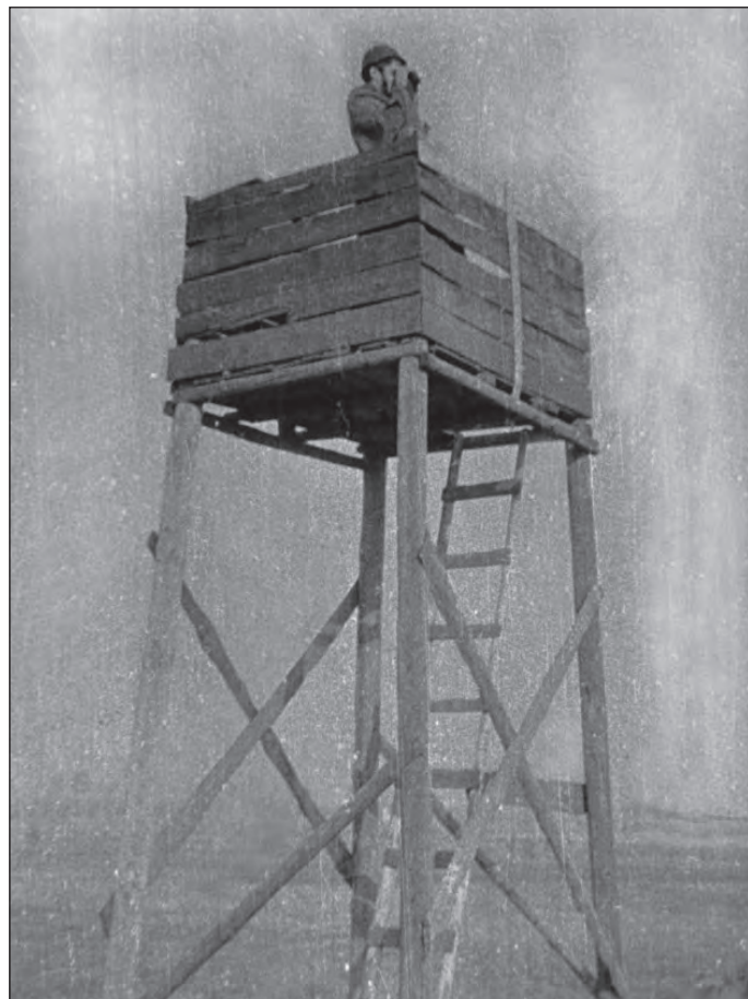
Fot. 3.7. Typowa wieża obserwacyjno-meldunkowa na posterunkach obsmeld. Fotografia z kroniki 25. Samodzielnego Batalionu Obserwacyjno-Meldunkowego
