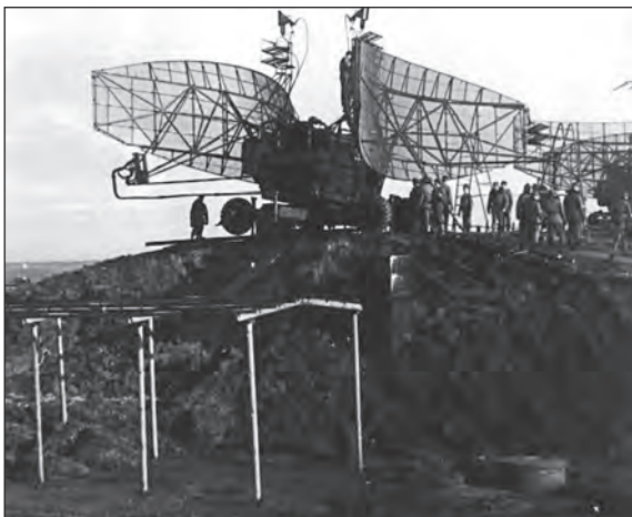
Fot. 6.57. W 1981 r. w Słupsku nastąpiło groźne uszkodzenie nasypu pod stacją K-66 „Karolina”
