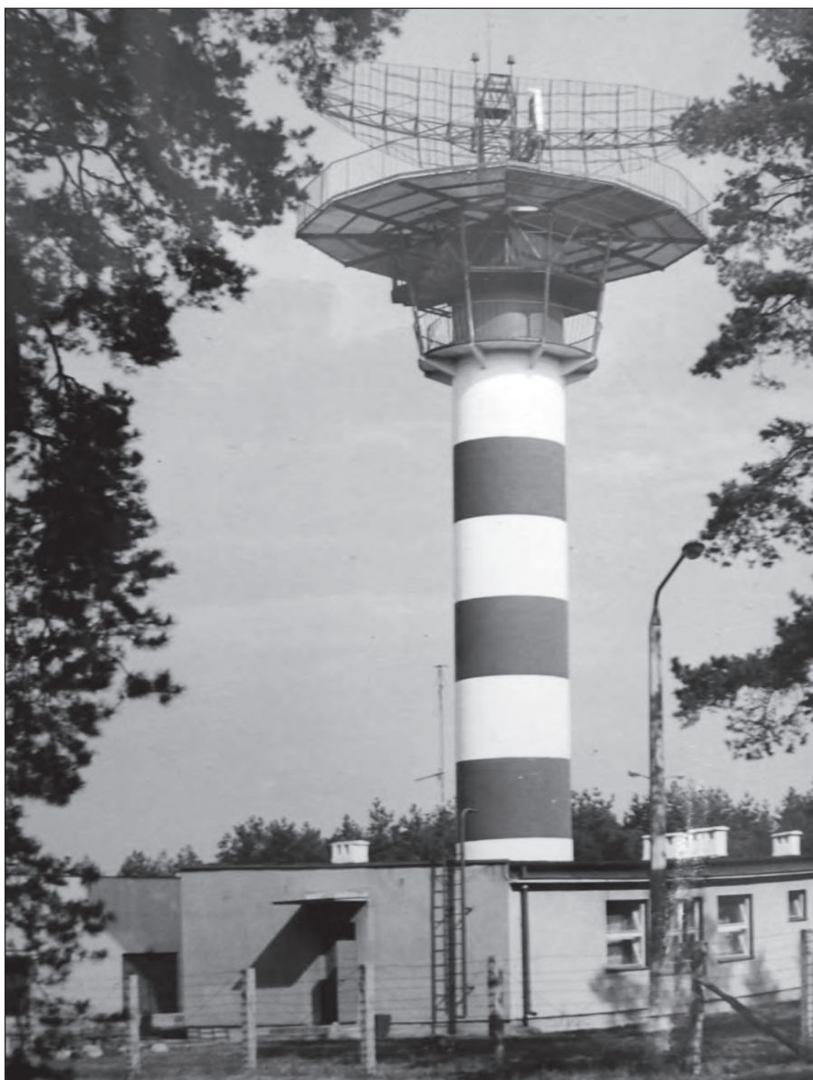
Fot. 6.88 Przylotniskowa stacja „AVIA-W”
