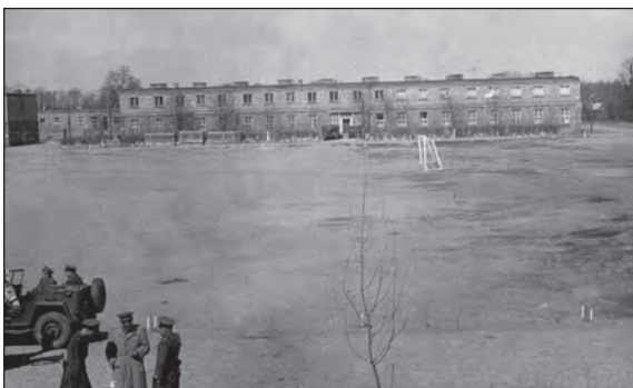
Fot. 9.1. Widok ogólny na plac apelowy szkoły i budynek oddziału szkolenia w Białobrzegach
