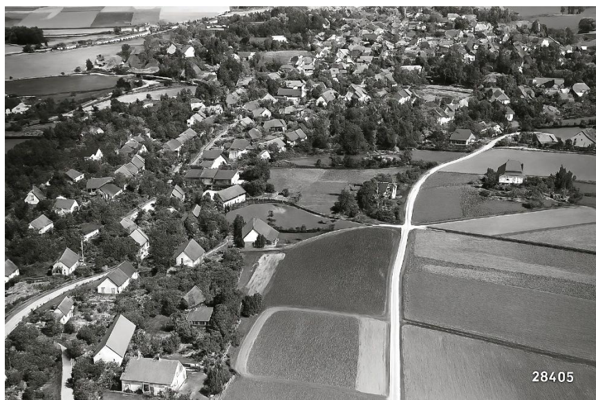
Sobieszów. Dolna część wsi. Zdjęcie lotnicze z października 1929 r.
