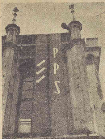
Fronton Dworca Głównego
