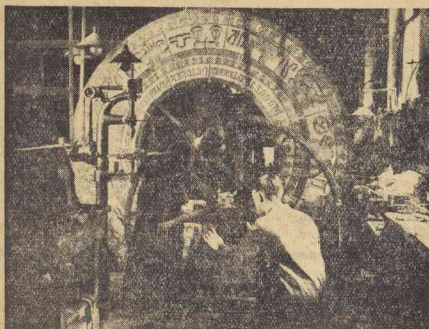
Rzemieślnicy oczyszczają i dostosowują część tarczy zegarowej, która była zainstalowana za czasów Henryka VIII-go. Pracowite napisy na tarczy widoczne są za plecami rzemieślników. Zegar ten przez długi czas był ozdobą wieżycy pałacu Hampton Court.
