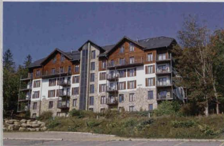
Nowy budynek hotelowy w Szklarskiej Porębie Średniej
