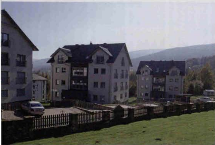
Zabudowa usługowa w minicentrum nad Kwisą
