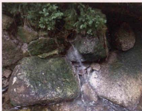
Miejsce zrzutu ścieków do ciek
