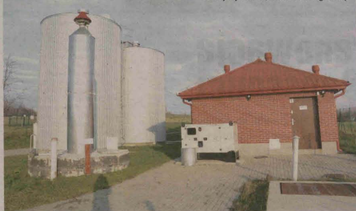
Stacja uzdatniania wody dla sołectwa Giebułtów ma wydajność 12,5 m sześć na godzinę.
