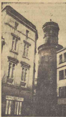
Zabytkowa wieża ochronna w Jeleniej Górze.
