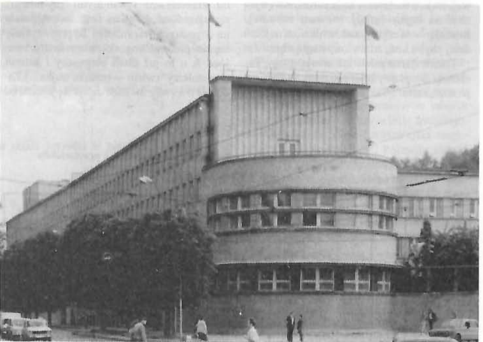
Miejskie Zakłady Elektryczne, ul. Pełczyńska nr 57
