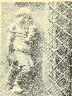
RZEBA PRZY WEŚCIU DO PIWNICY RATUŠA WROCLAWSKIEGO
