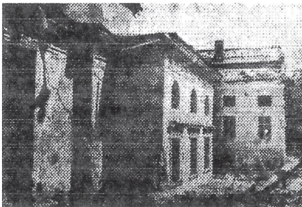
Zniszczony w czasie wojny budynek Ossolineum
