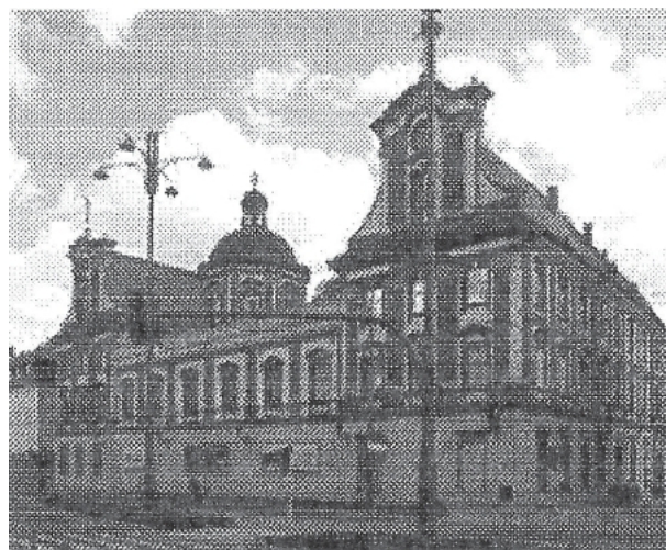
Ossolineum we Wrocławiu po jubileuszowym remoncie. Widok od ul. Grodzkiej i Szewskiej
