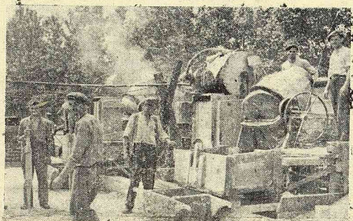
Betonarka przy pracy
