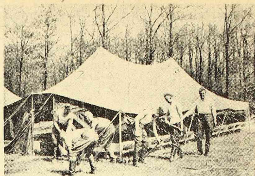
Ostatnie prace przy rozpinaniu namiotów
