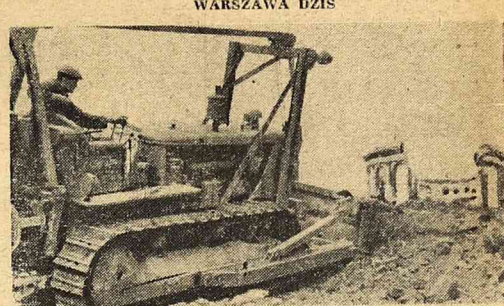
Złotce przedstawia maszynę do usuwania gruzu, przy pracy na Placu Trzech Krzyży w Warszawie.
