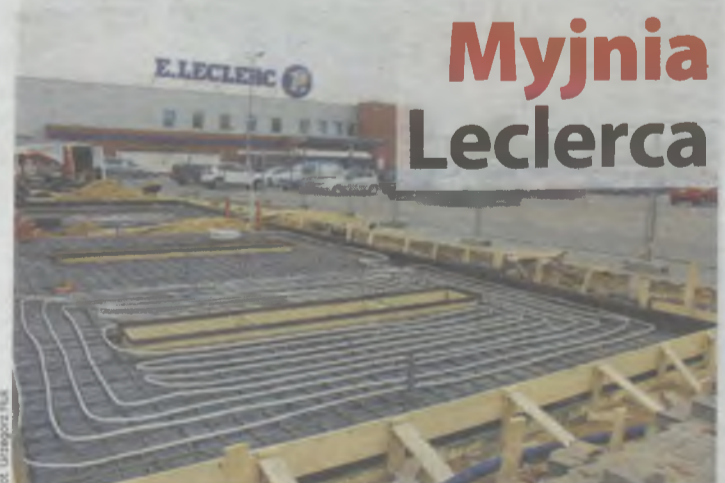
Fundament już jest
