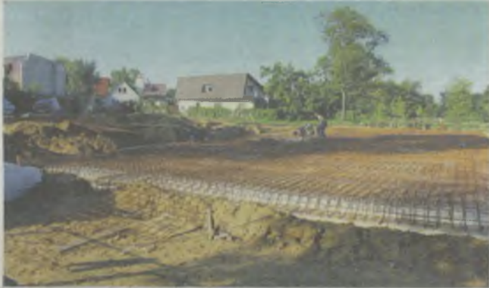
Fundament już się robi
