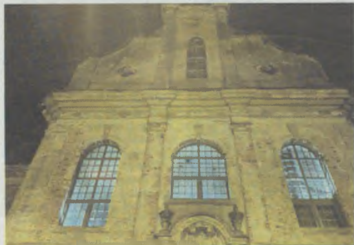
W kościele wymieniono już okna
