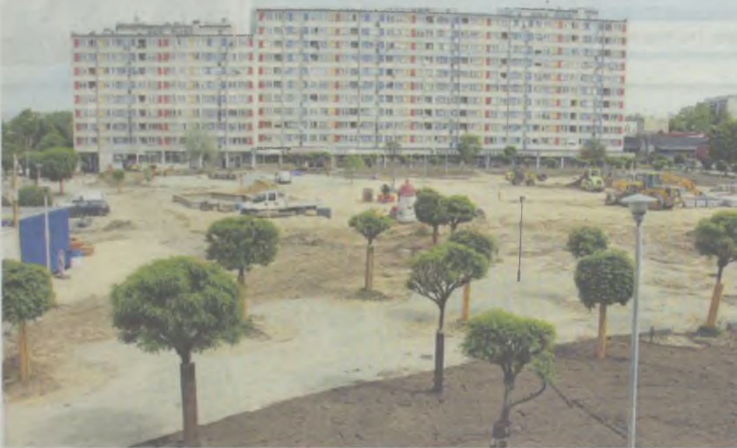
Plac Zwycięstwa - wielkim placem budowy
