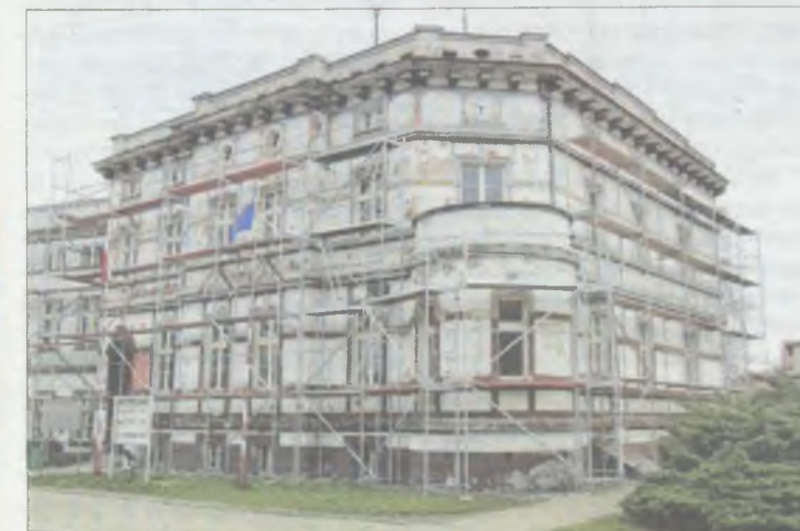
Intensywne prace trwają
