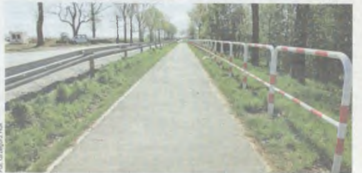
(hag) Część dobroszycka ścieżki jest już gotowa
