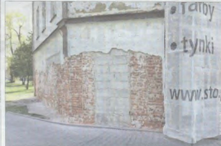
Odkryto dawne wejście
