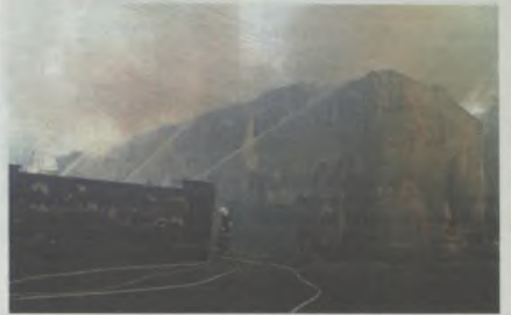
Tak zniszczono bierutowski zabytek
