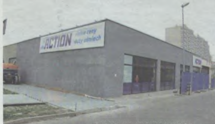
Trwają wciąż intensywne roboty
