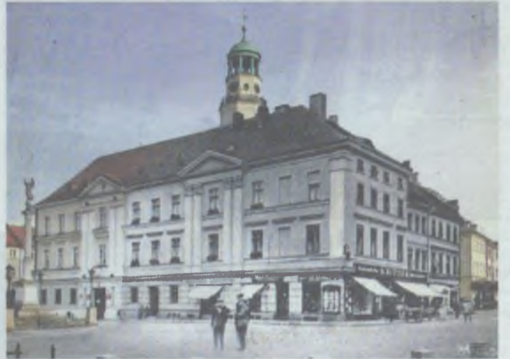
Dawniej i dziś - w jednym miejscu
