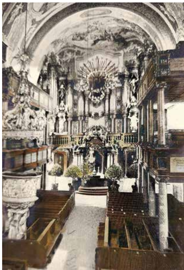
Kościół Łaski Cesarskiej w Jeleniej Górze – widok na empory XIX w.
