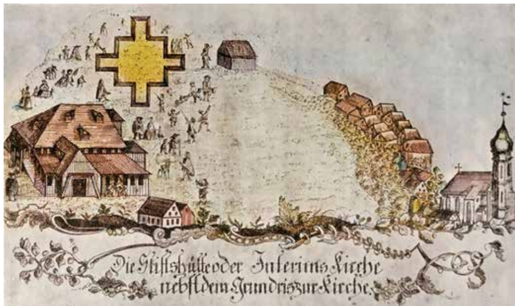
Początek budowy kościoła
