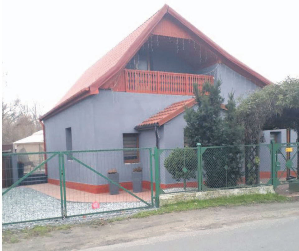
W tym miejscu jeszcze w latach 50. XX wieku była strażacka remiza
