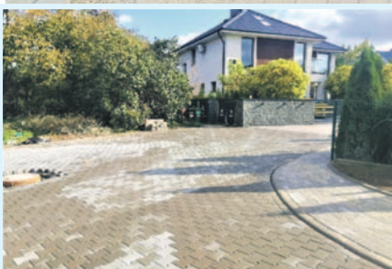
Trwa budowa drogi i chodników na ul. Okólnej
