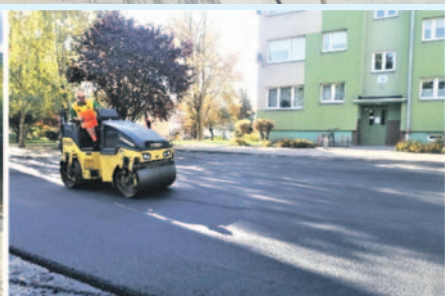
Rozpoczął się drugi etap remontu ulicy Kamiennej
