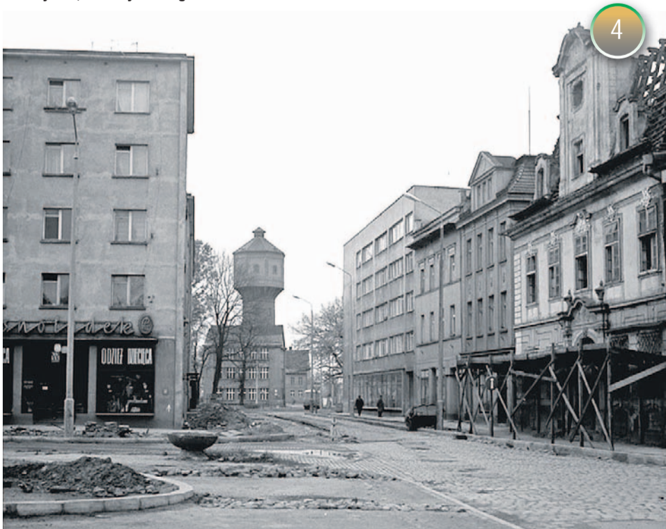
Zdjęcie zrobiłem w 1971 roku - widać budynek, który spłonął w 1967
