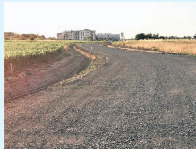
Kolejna droga ulgi jest w trakcie budowy
