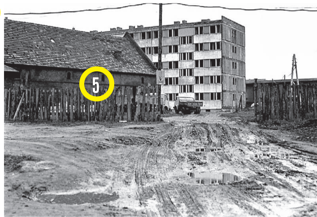
Prawa strona w kierunku Odry - po lewej stodoła (nr 5) w tym miejscu będzie Dom Handlowy Kwadraciak, po prawej w głębi pierwszy budynek na Osiedlu Bolesława Chrobrego, widać klatkę nr 32
