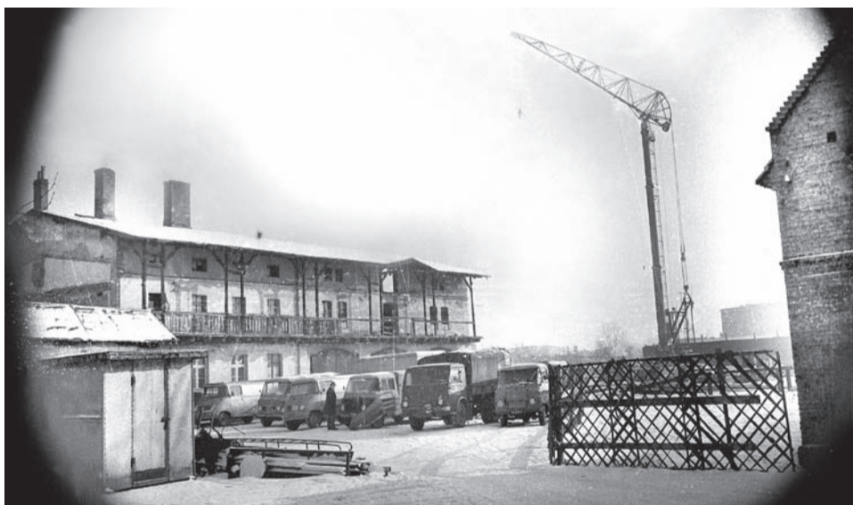
Na zdjęciu, które zrobiliśmy w 1968, jest widoczny budynek z balkonem przy ulicy B. Chrobrego - w momencie robienia tej fotografii był w trakcie wyburzania. W tym domu mieszkała na parterze pani Basia, a na piętrze jej koleżanka Janka
