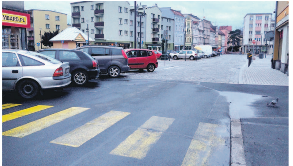
Przeście z żółtymi pasami na ul. Brzeskiej parę metrów dalej nadal istnieje i wprowadza w błąd
