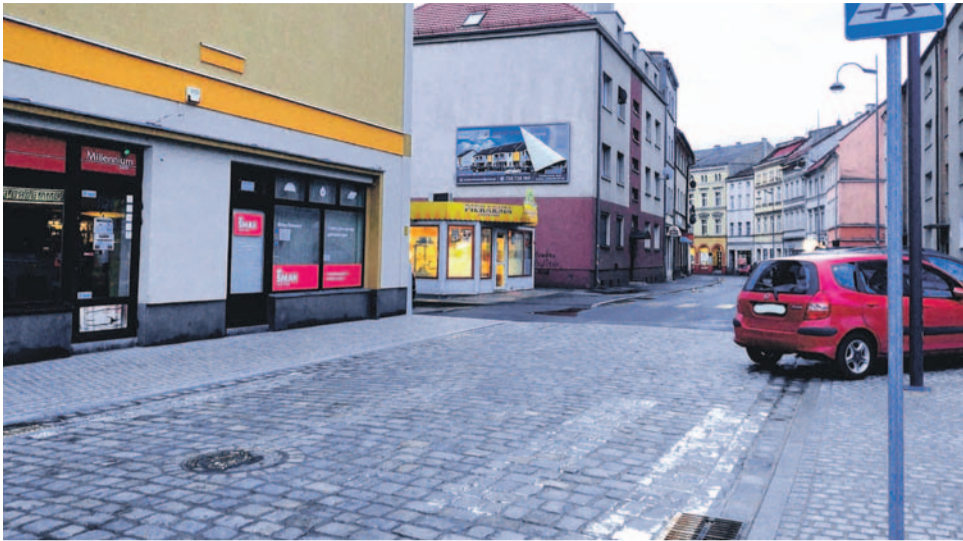
Przeście dla pieszych ze słabo widocznymi białymi pasami oznakowano po zakończeniu remontu.
