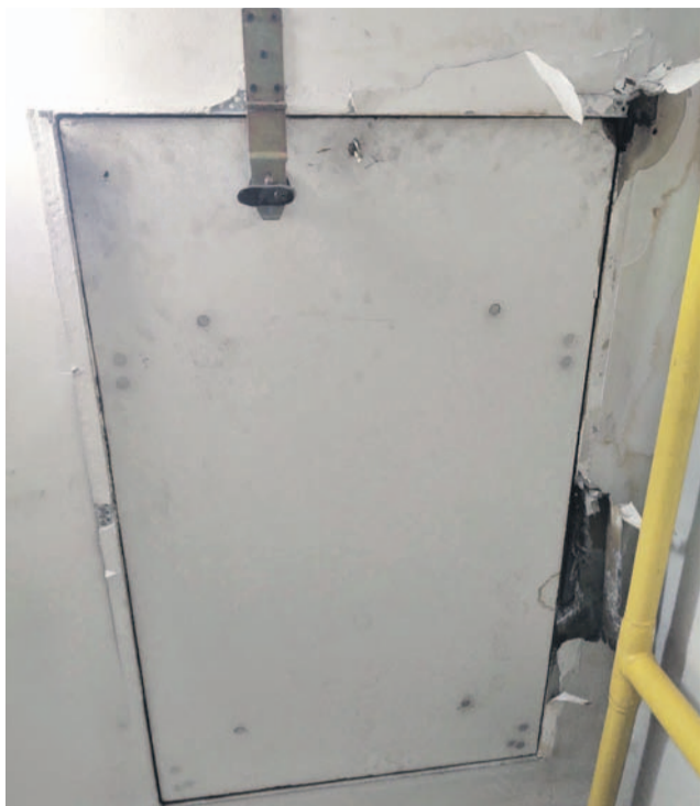
Tak wygląda wyjazd na dach
